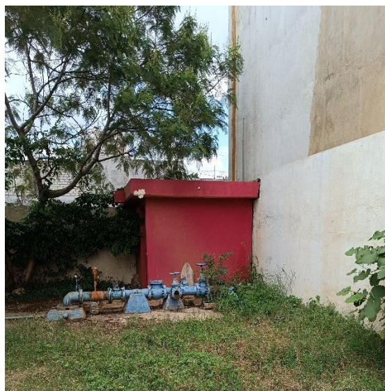
IMAGEN 2. SE OBSERVA PARTE DE LA CASETA DE CLORACIÓN, DE IGUAL FORMA PARTE DEL TREN DE DESCARGA
