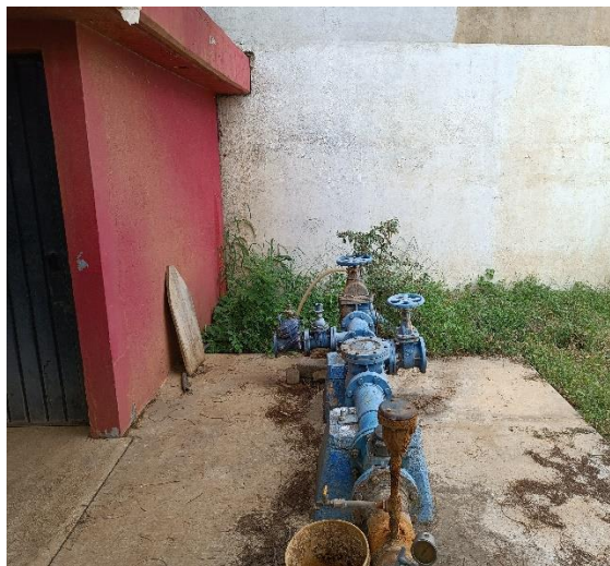
IMAGEN 1. VISTA DEL TREN DE DESCARGA DEL POZO EXISTENTE.
